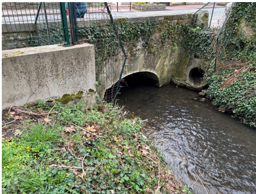
Pont en maçonnerie sur la route d'Étampes
