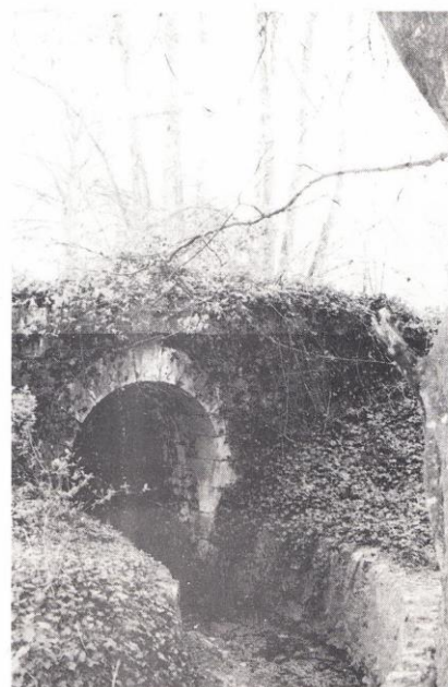
Pont sur la Gironde Photo J.-L. Prêter
