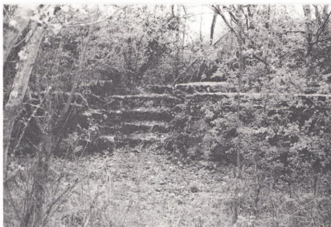
Bâtiment en ruine situé près du quai de l'ancienne gare de Ponthévrard
