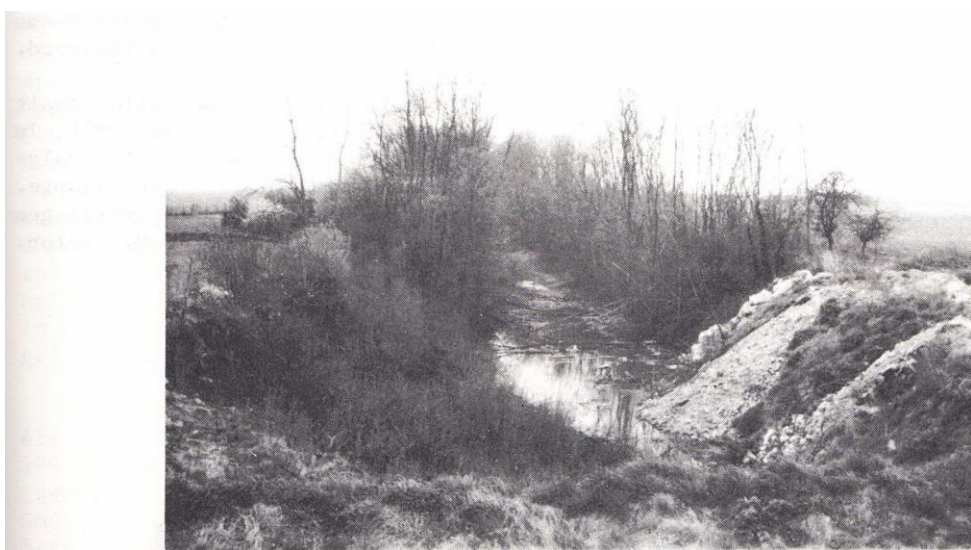
En 1985, l'emplacement de l'ancienne ligne de chemin de fer Paris-Chartres disparaît petit à petit sous les remblais. Photo J.-L. Prêter
