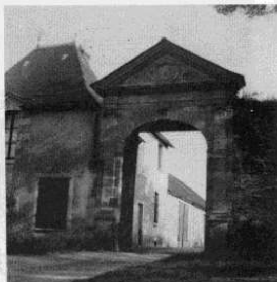
Porte nord de la ferme bâtie en 172
