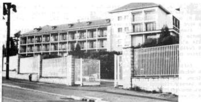
Maison de retraite de la Banque de France - Photo J.-L. Pâtes
