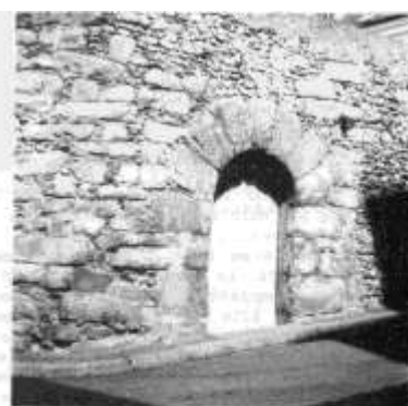
Entrée qui donne accès au puits de la "Fleur de Lys" Photo Ganiot
